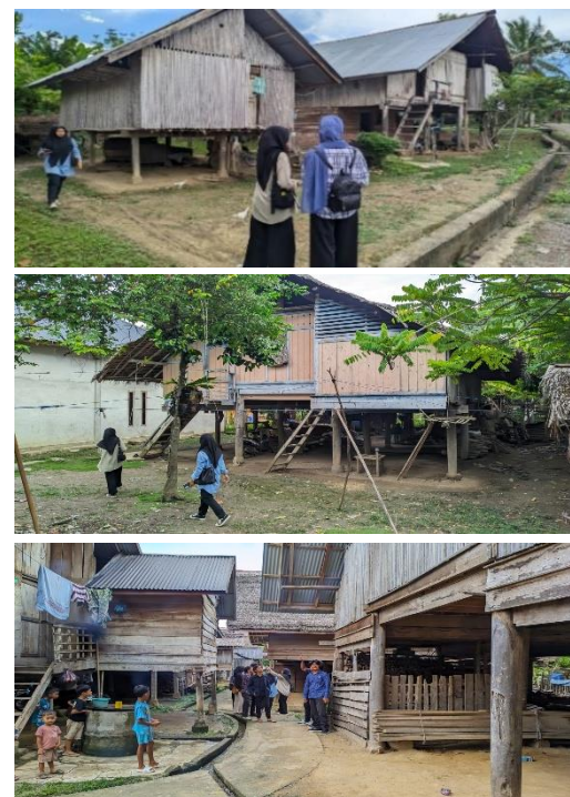
Gambar 3: Kondisi Fisik Rumoh Aceh di Gampong Mureu
