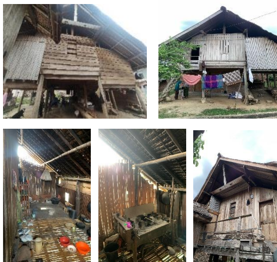
Gambar 1: Kondisi Fisik Rumoh Aceh di Gampong Mureu Baro.
